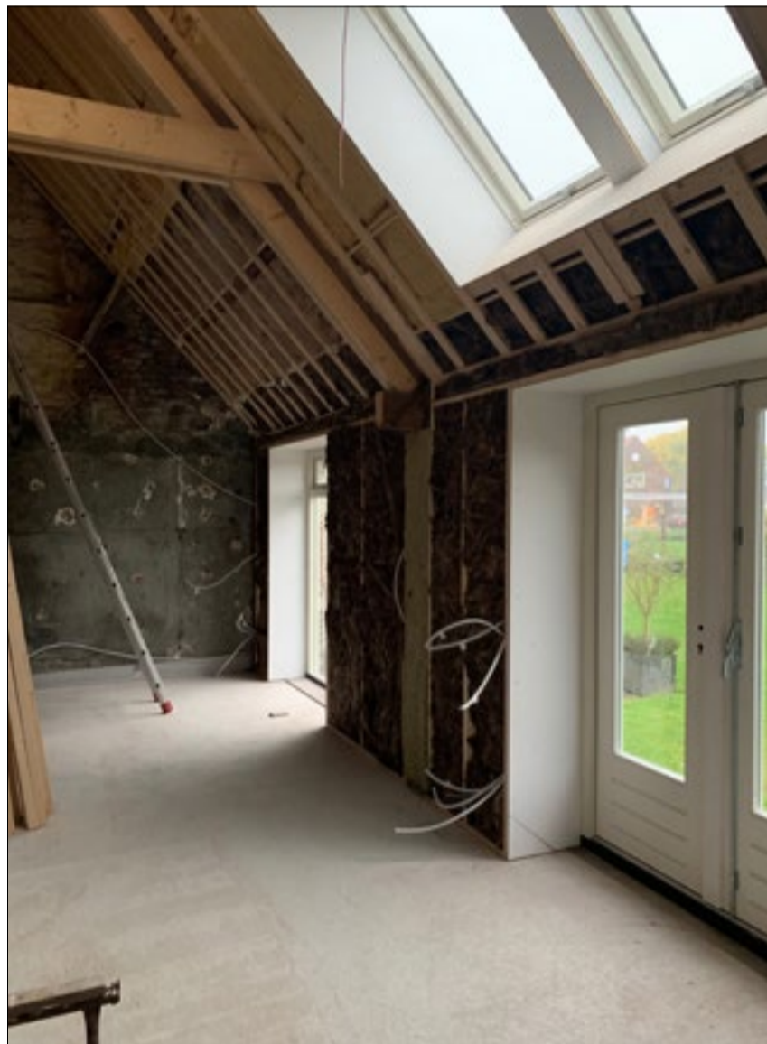
Isolatie binnenzijde oude woning. (foto: Edzo Oosterhuis)
