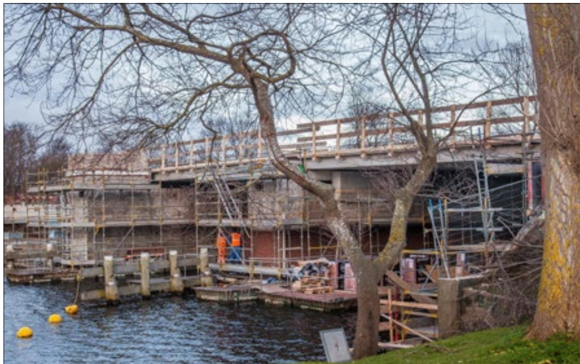
Het oude beweegbare brugdek van de Koningin Julianabrug is vervangen door een vast dek. | Foto: Adrie van Duijven-
