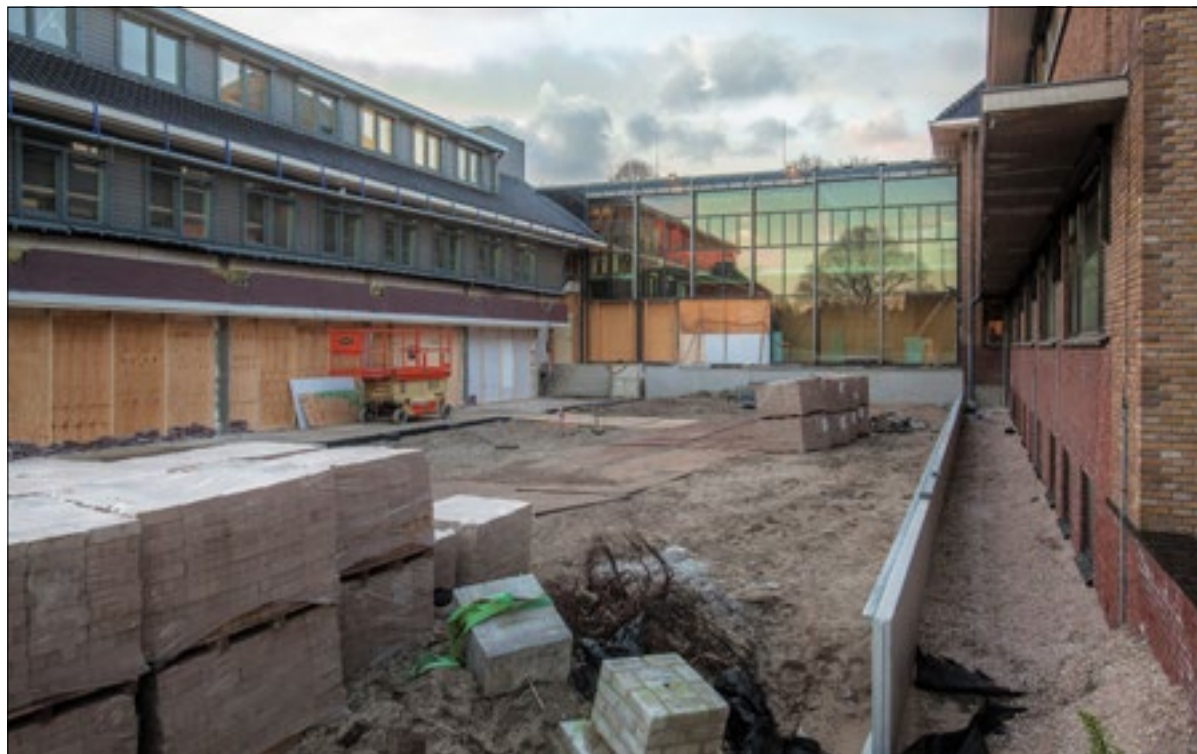
De werkzaamheden aan het gemeentehuis. Links komt de nieuwe hoofdentree. | Foto: Adrie van Duijvenvoorde
