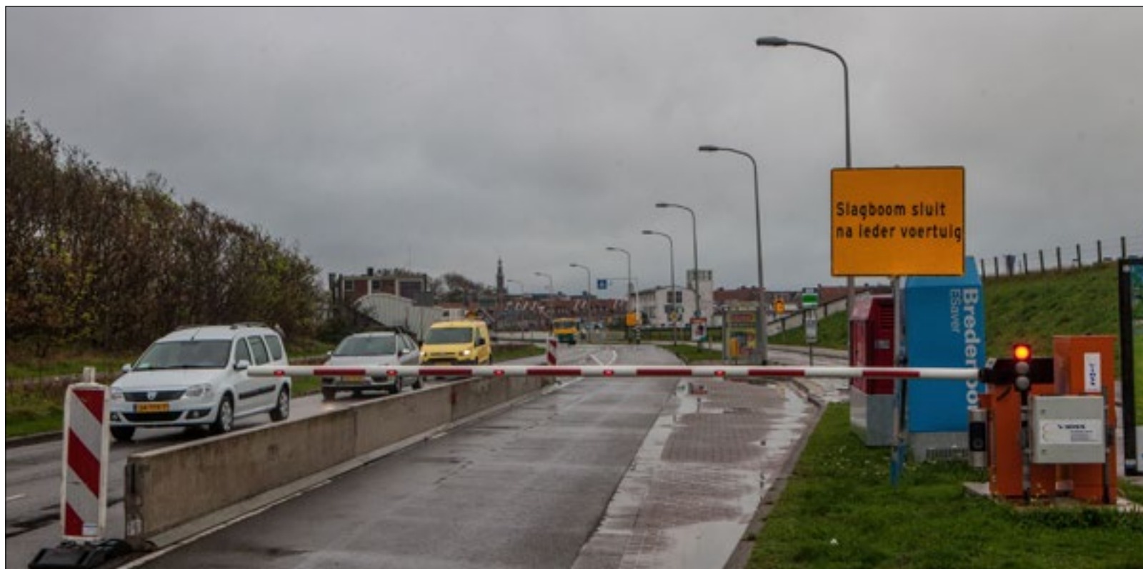
Eind deze maand gaat de proef in voor het openstellen van de Binnensluis. | Foto: Adrie van Duijvenvoorde
