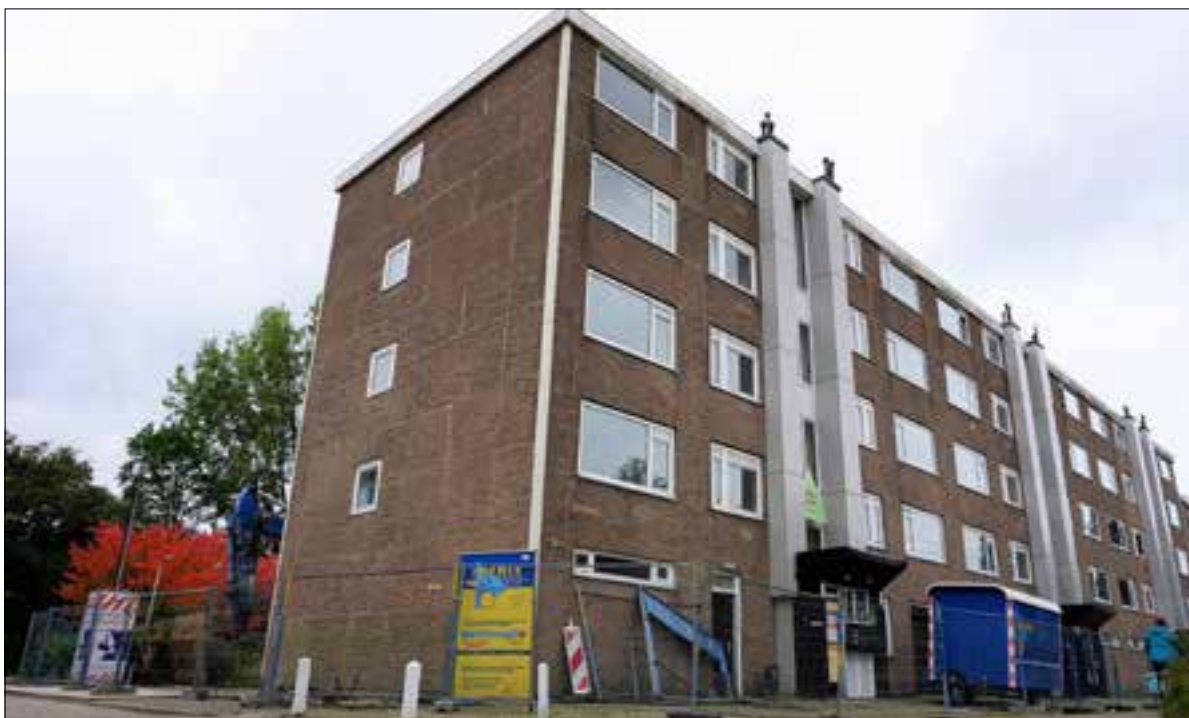
De flats aan de Helmburgweg en de Boerslaan worden volgende maand gesloopt,
