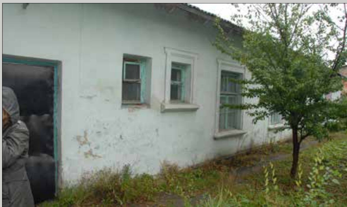
Door een gift van de Commissie Oekraïne kan de verbouwing van de daklozenopvang in Zdolbuniv worden voortgezet. | Foto: PR
