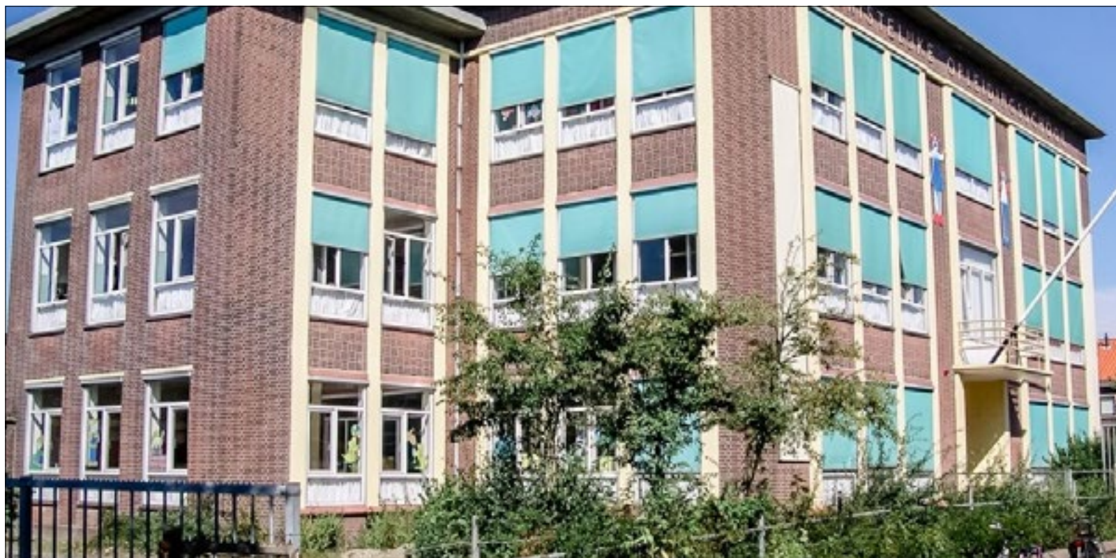
De Christelijke Opleidingsschool aan de Parklaan in Katwijk. | Foto: pr
