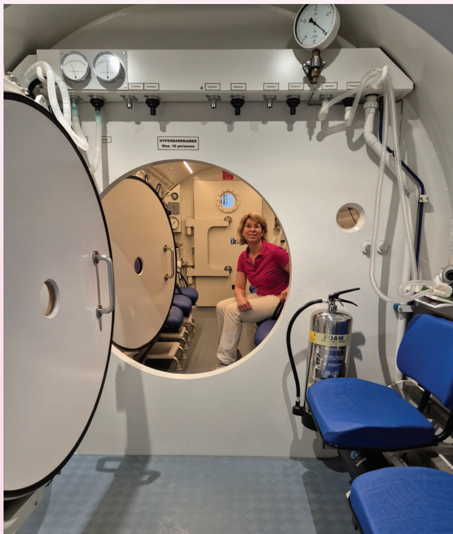
Hyperbaar verpleegkundige en operator Atsje in de tank. Op de voorgrond is de sluis zichtbaar. Via deze sluis kan de patiënt uit de tank zonder dat de behandeling voor de andere patiënten gestopt hoeft te worden.
