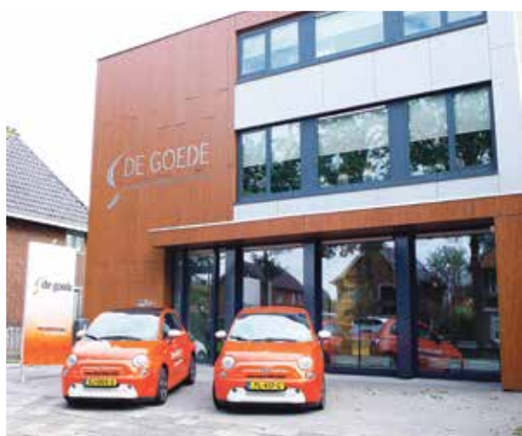
Een combinatie van houten panelen, zwarte stalen kozijnen en een gevelbeplating in licht-antraciet zorgen er voor dat het pand goed zichtbaar is en een vertrouwd gevoel geeft.
