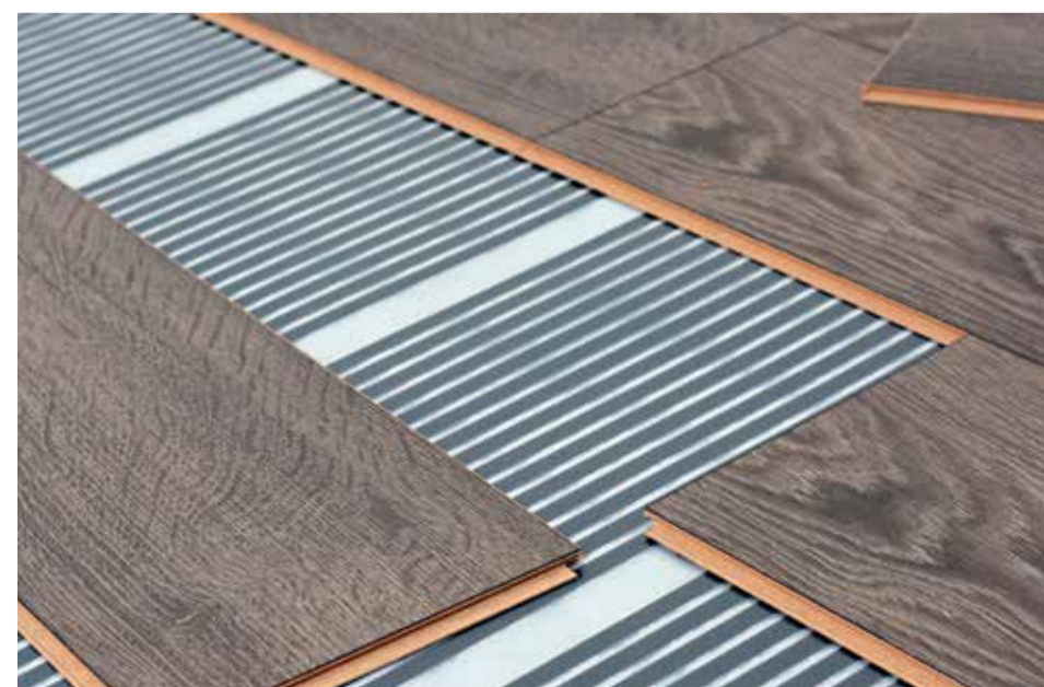
isolerende ondervloeren en de folie waarin de infraroodverwarming zit verwerkt
