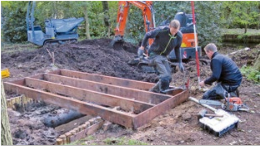
Aanleg van een houten bruggetje.
