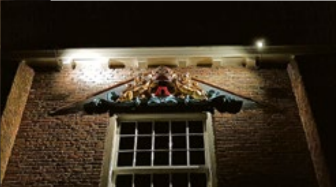
Omdat het een rijksmonument is had het nog wat voeten in aarde voordat de verlichting aangebracht kon worden.
