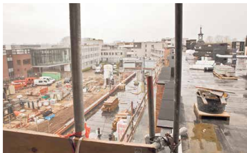
De bouw is nog in volle gang
