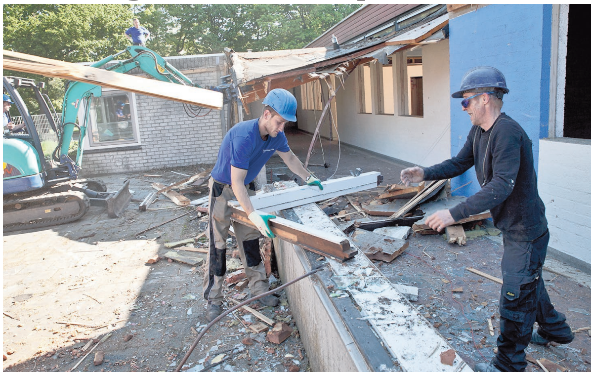
Slopers van RW Groep aan het werk
