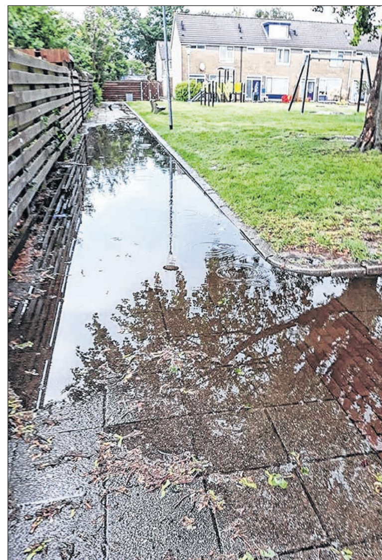
■ Het regenwater in het Ellertsveld wordt niet goed afgevoerd.
