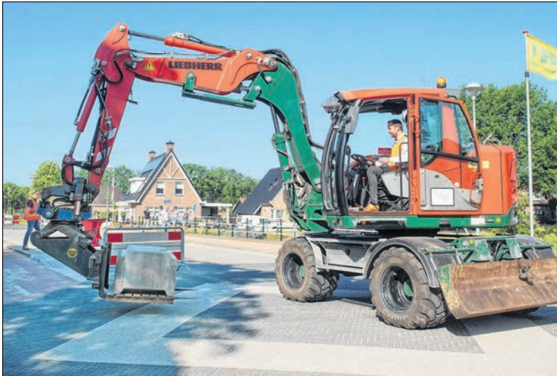
■ Wethouder René van der Weide verwijdert het laatste betonblok van de Ermerweg.
