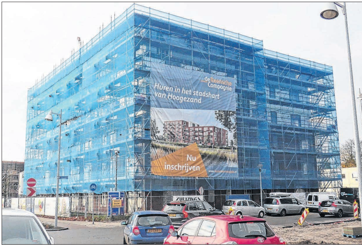
■ De nieuwe Atlantaborg, hoogste punt bereikt en nu de binnen afbouw, waarna komend voorjaar waarschijnlijk de eerste bewoners erin kunnen.
