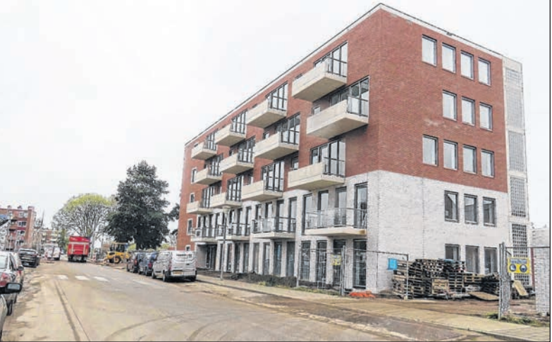
■ De bouw en aanverwante werken vorderen. Het appartementencomplex aan de Erasmusweg tussen Kieldiep en Kerkstraat (foto) nadert ook de voltooiing.
