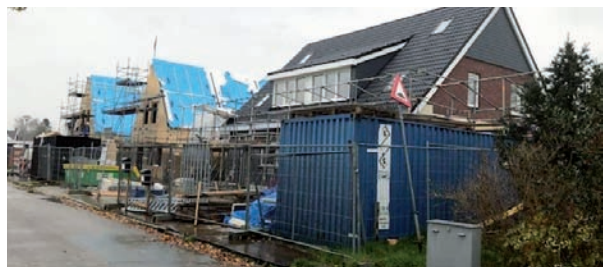
Hoogste punt bereikt bij bouw Oosterstraat
