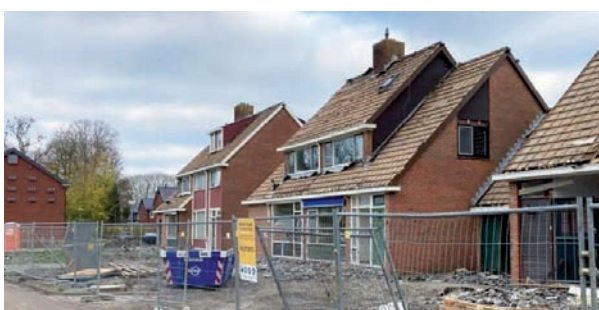
Foto: Heijmans Woningbouw Noord Sloop woningen deelgebied 2
