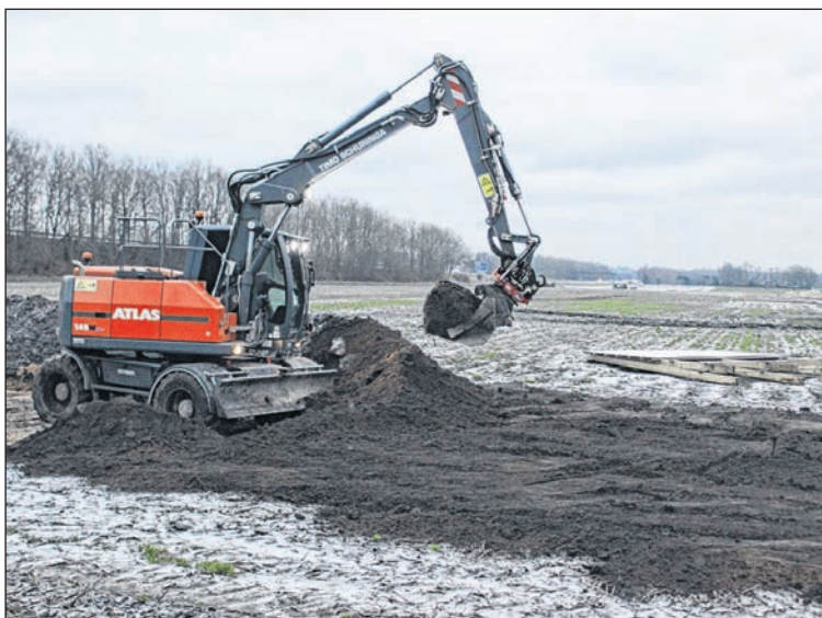
■ De werkzaamheden op het Ambachtterrein in Rolde-Zuid zijn gestart. (foto: Henry Koops)
