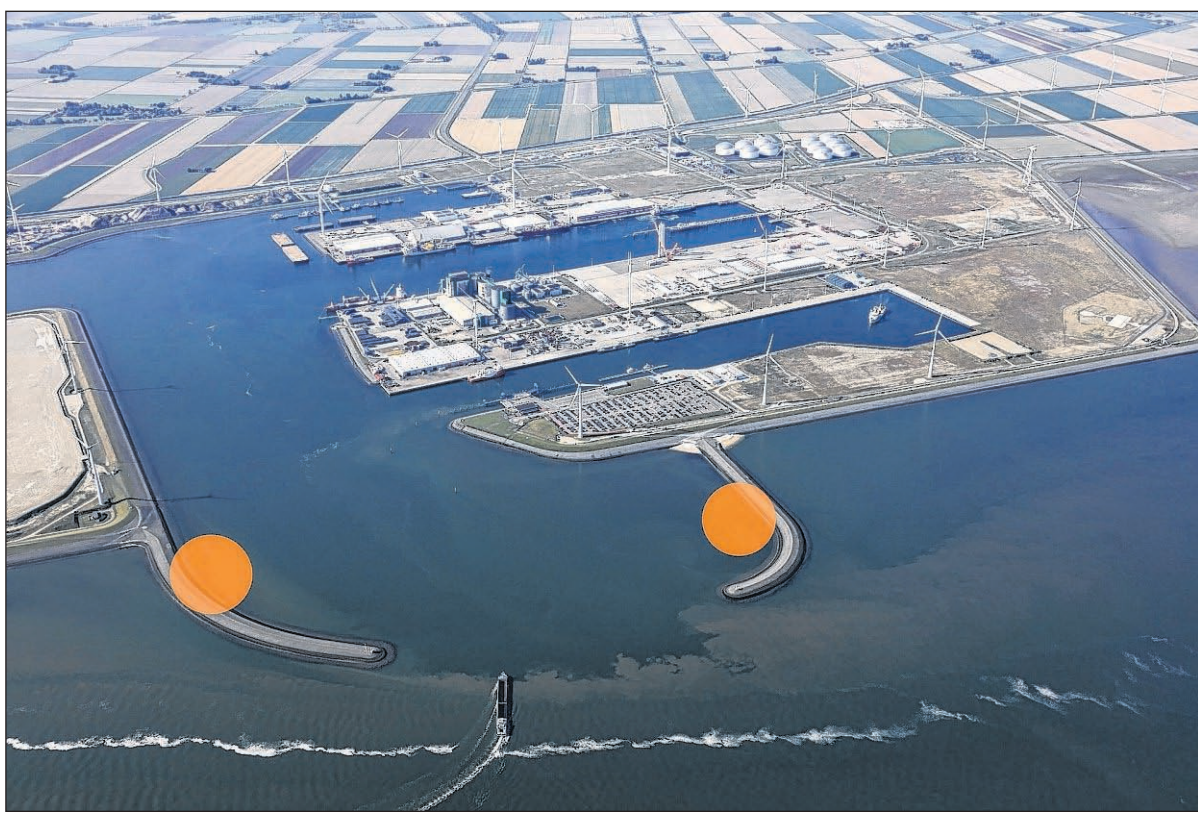
■ Op de beide strekdammen van de Eemshaven zullen grote windturbines geplaatst worden.
