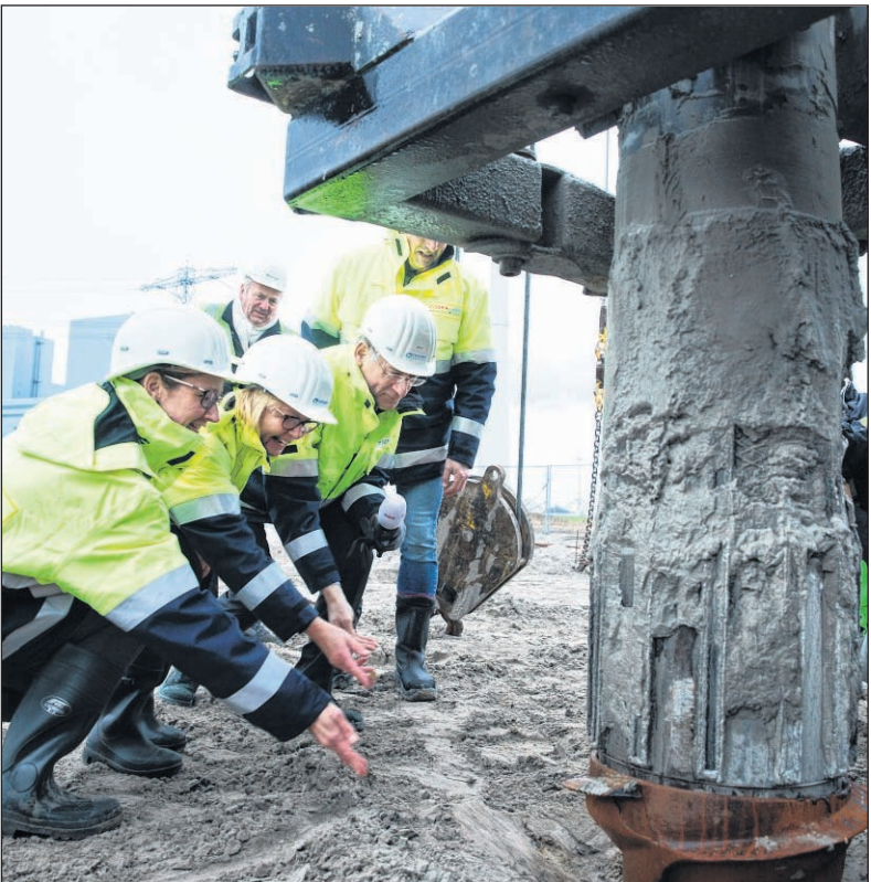
■ Vier jaar geleden heeft TenneT samen met haar Deense partner Energinet.dk de eerste heipaal geplaatst voor de bouw van het Nederlandse converterstation voor de COBRA-kabel. Links op de foto onder anderen toenmalig burgemeester van de gemeente Eemmond, Marijke van Beek.
