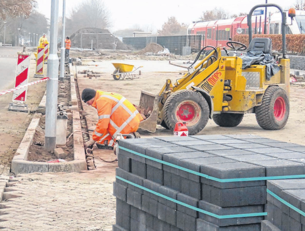
■ De aanleg van meer parkeervoorzieningen bij Station Hoogezand.
