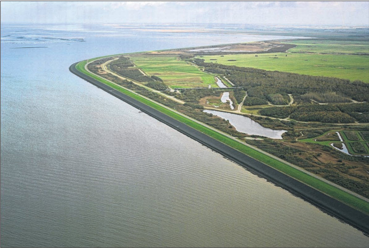
■ De zeedijk bij Lauwersoog (foto: Rijkswaterstaat).
