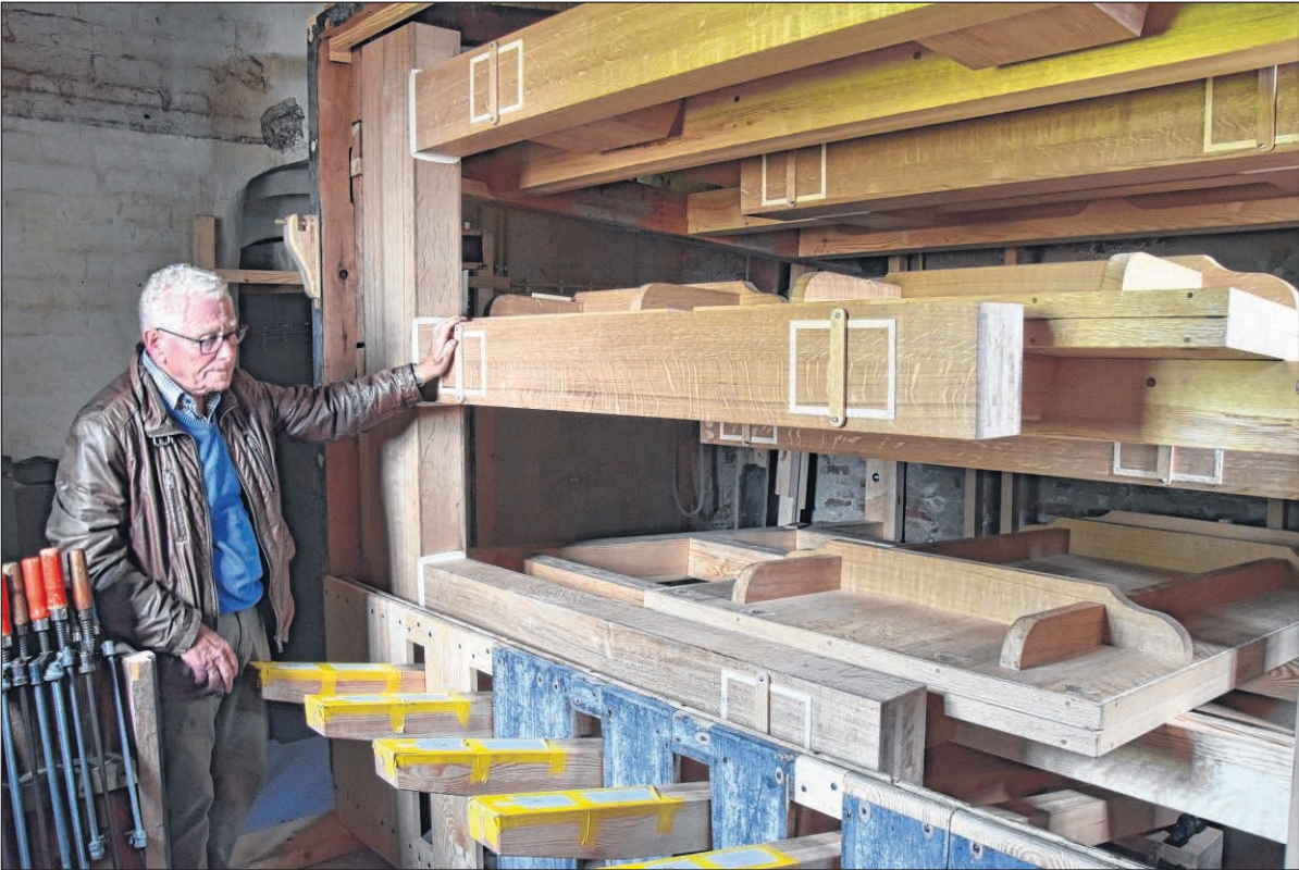
■ Jan Oostindien bij het balghuis in de torenruimte, met de deels gereconstrueerde en vernieuwde stelling met nieuwe spaanbalgen en toebehoren. De horizontale windkanalen brengen de orgelwind van de mondingen (achter de luikjes) van de vijf balgen naar een staand kanaal. Dit kanaal is aangesloten op de twee historische kanalen die onder de vloer naar het orgel gaan.
