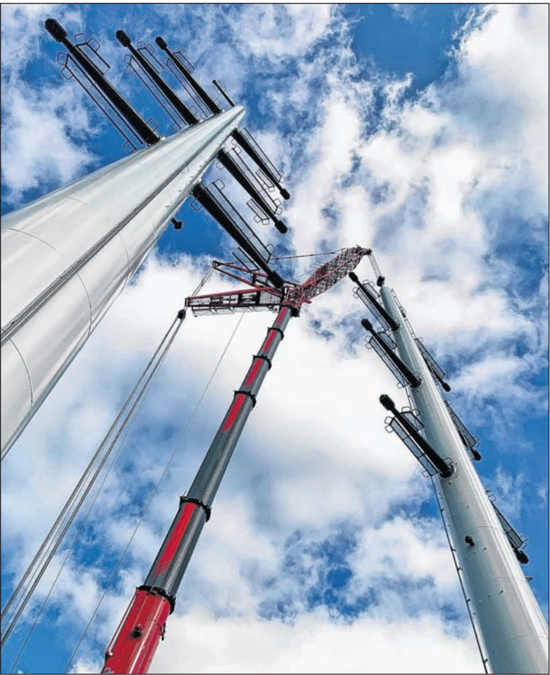
■ De eerste masten voor de nieuwe stroomsnelweg zijn geplaatst. Foto: TenneT
