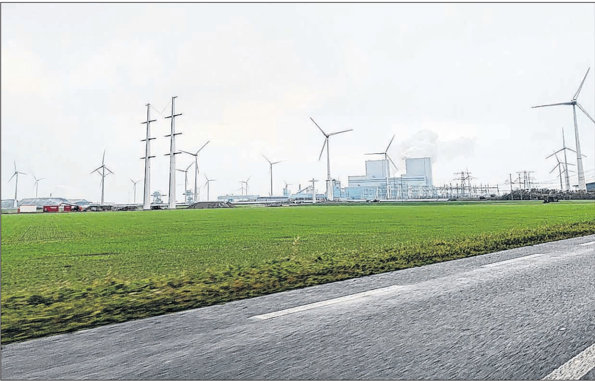
■ De eerste mast voor de Eemshaven-Vierverlaten 380 kV-verbinding bij Eemshaven is inmiddels geplaatst.
