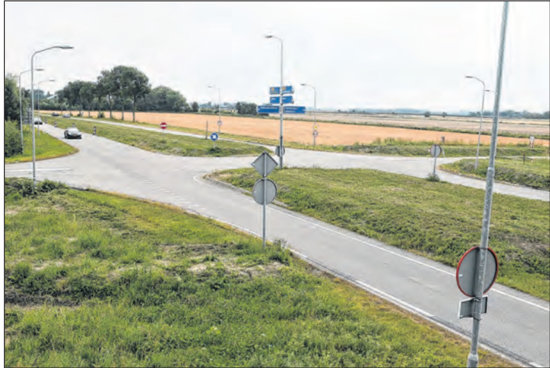
■ De kruising ter hoogte van Wehe-den Hoorn wordt omgebouwd tot rotonde. Foto: Ronnie Afman.
