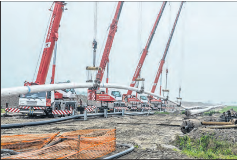
■ Een van de waterleidingen hangt in de takels.
