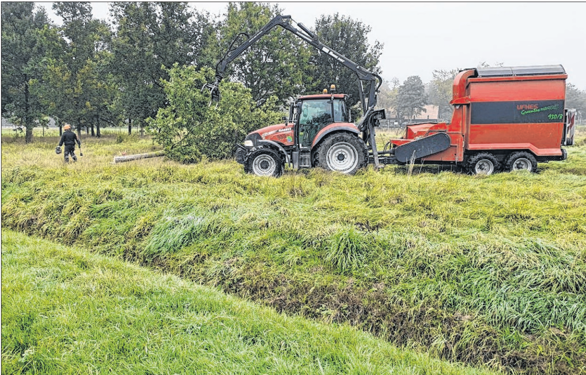
■ Met het verwijderen van wat dunne bomen zijn vorige week de werkzaamheden ten behoeve van de aanleg van de zonneweide in Glimmen van start gegaan.
