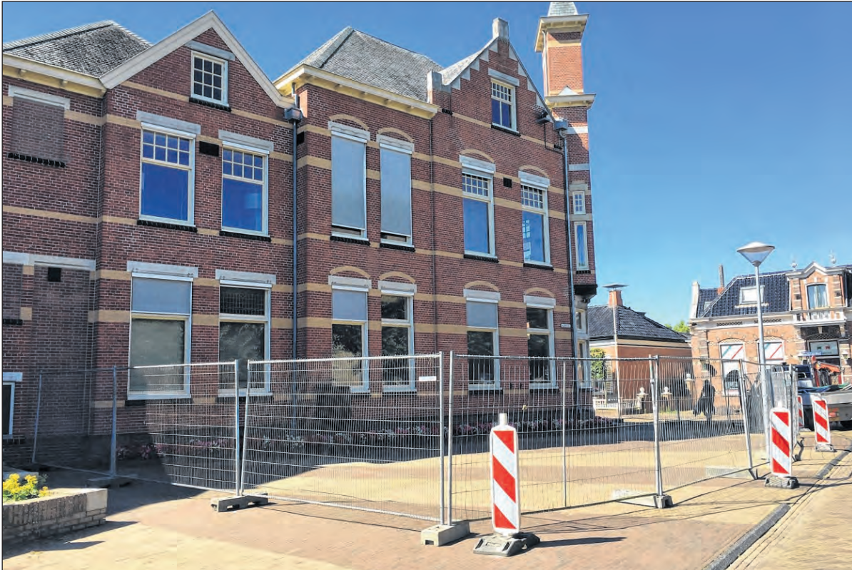
UTHUIZEN - Leien dakpannen van het gemeentehuis in Uithuizen zijn woensdag losgekomen en op straat gevallen. Hoe dit kon gebeuren, is nog niet duidelijk. Om gevaarlijke situaties te
