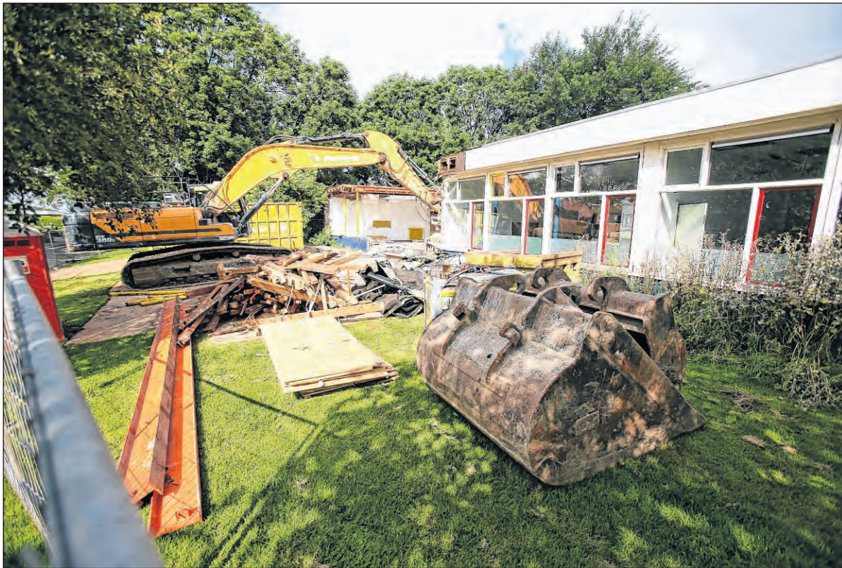
BAFLO - De sloop van de voormalige basisschool Ichthus aan de Gebroeders Gootjesstraat in Baflo is begonnen. Het pand staat al geruime tijd leeg omdat de school zijn intrek heeft genomen in een nieuw onderkomen elders in het dorp. Als de sloopwerkzaamheden klaar zijn, wordt er op de
