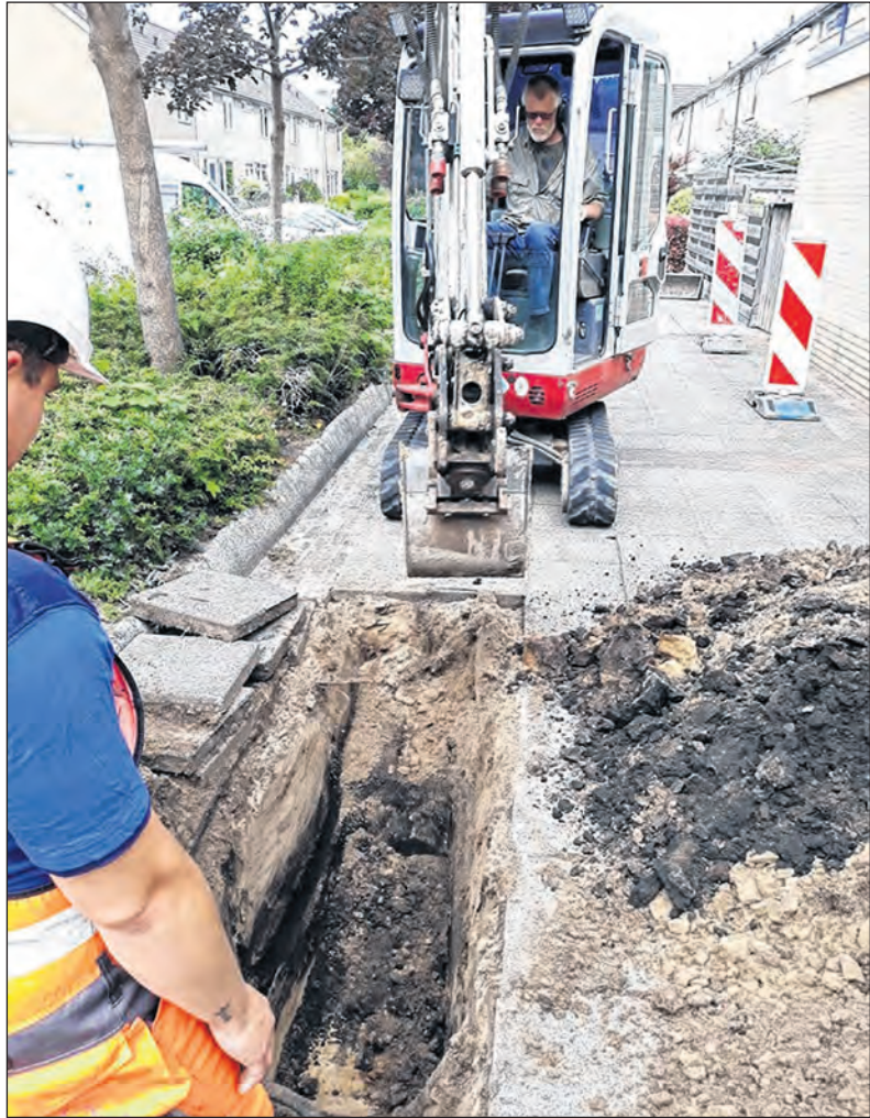
■ Deze week is begonnen met het vervangen van de waterleiding in het Ellertsveld.
