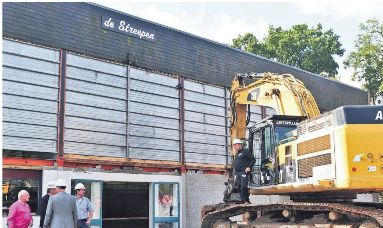
De eerste zet aan de sloop van de oude sporthal de Streepen is gemaakt. Aan de binnenzijde van de oude hal zijn de eerste sloopwerkzaamheden gestart. Deze week wordt de sloop ook aan de buitenzijde zichtbaar. Wethouder René Dekkers nam afgelopen maandag zelf plaats op de sloopkraan om letterlijk de eerste zet te geven. De sporthal wordt gesloopt door Slopersbedrijf A. van Liempd uit Sint-Oedenrode. Na de sloop start de nieuwbouw in oktober.
