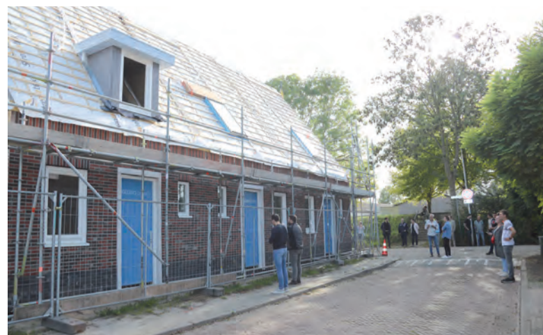
Foto: Om het nieuwbouwproject voor starters in Nieuw-Vossemeer van de grond te krijgen, hebben veel partijen hun steentje bijgedragen. De lokale projectontwikkelaar, bouwver, gemeente, Stadlander en de Dorpsraad. Bij het hoogste punt van de bouw mocht dus wel even worden stilgestaan.
