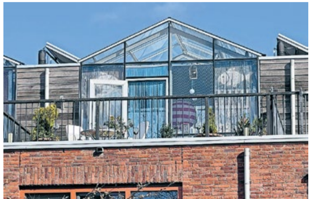
Woningbouw op de grens van Den Haag en Wateringen, een dakopbouw.
