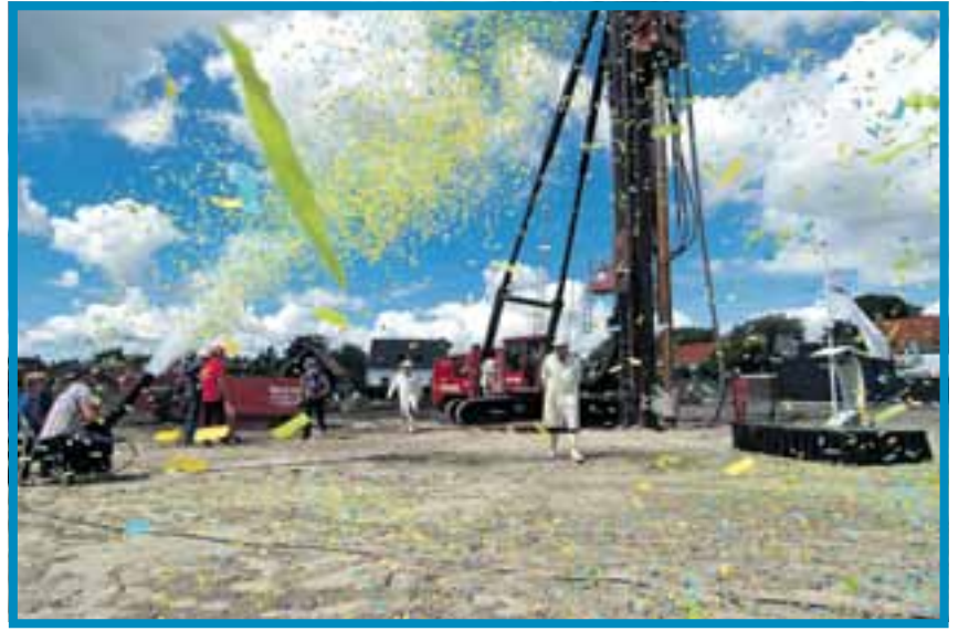
Van bouwproject 'Hart van Dirksland' werd donderdag 12 juli, na vele jaren van voorbereiding, de start van de werkzaamheden ingeluid door het slaan van de eerste paal én een regen van confetti over de bouwplaats.
