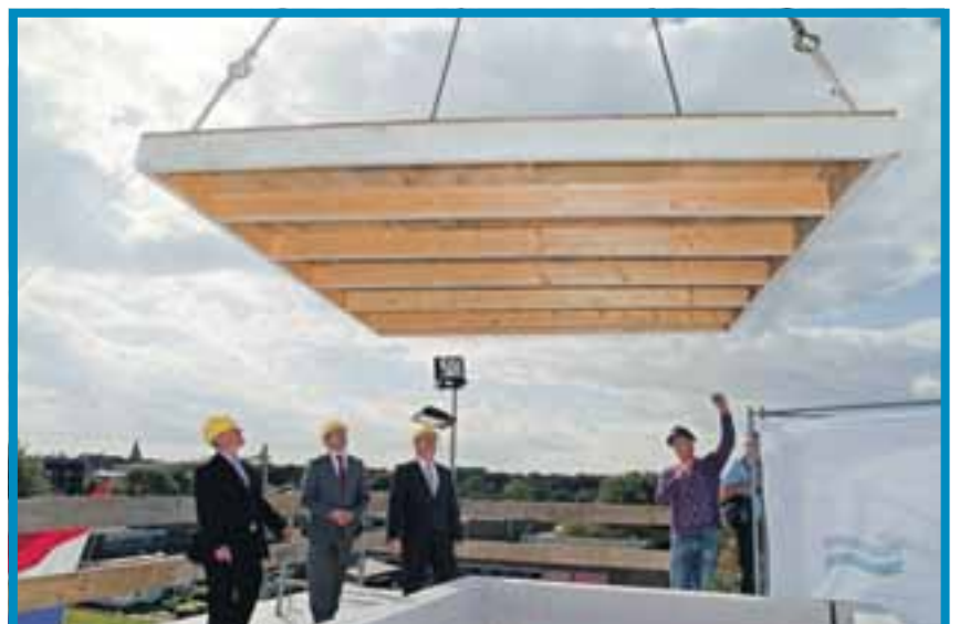
De in aanbouw zijnde nieuwe huisvesting van zorgcentrum 'De Vliedberg' in Ouddorp bereikte vrijdag 28 september het hoogste punt.
