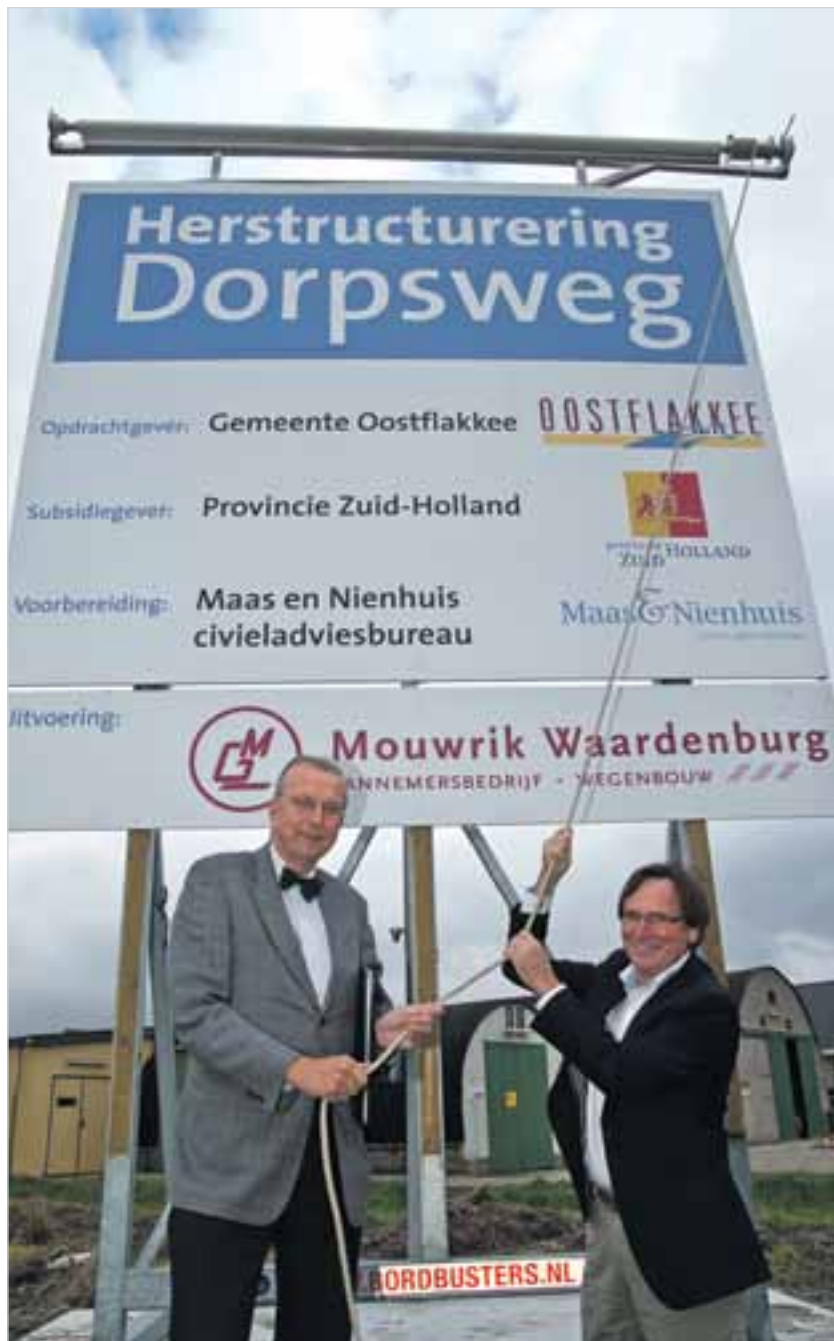
Met het onthullen van een bouwboard werd de start gegeven aan de werkzaamheden. Rechts wethouder Willy Heintjes.
