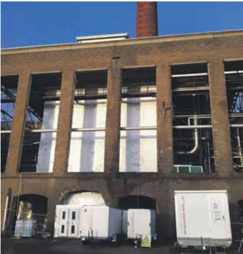
Asbestverwijdering bij de Suikerunie.
