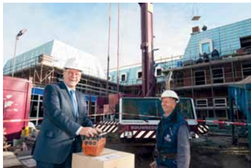
Tollenaar plaatst met afstandsbediening de laatste schoorsteenplaat.
