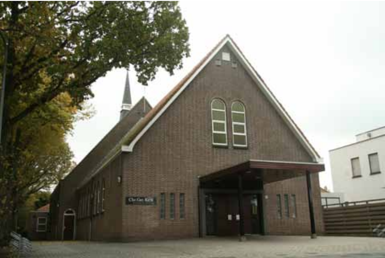
De christelijke gereformeerde kerk te Middelharnis
