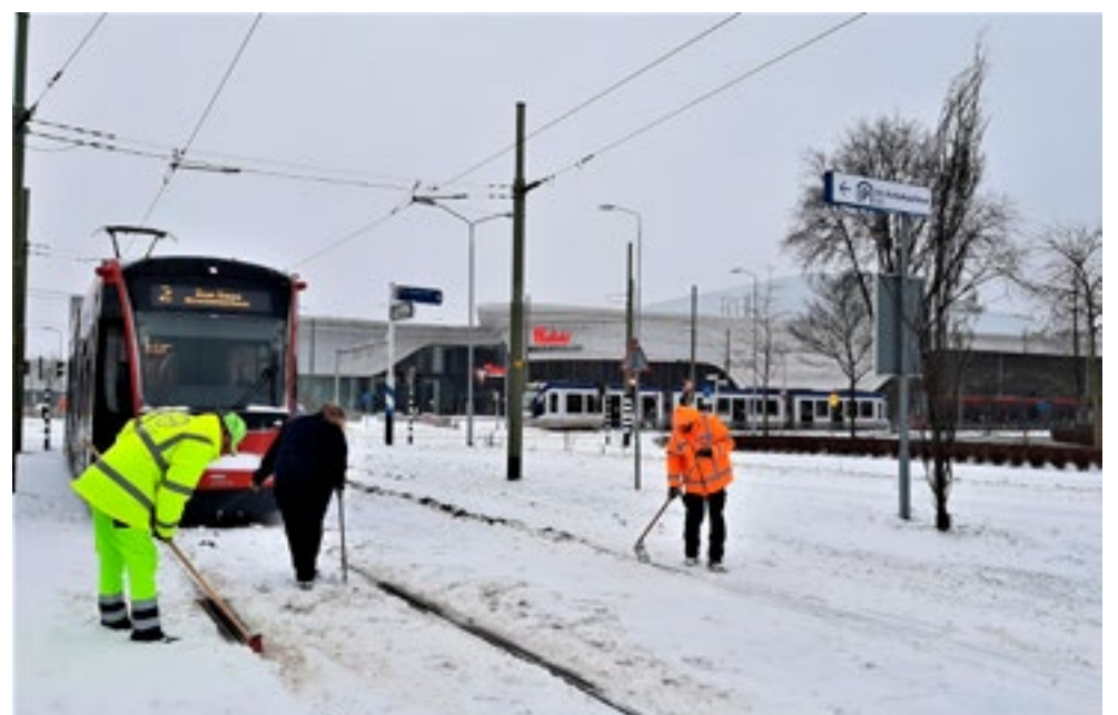
Voor de tram uit sneeuw vegen om de rails berijdbaar te houden (foto: Hans van Veen).
