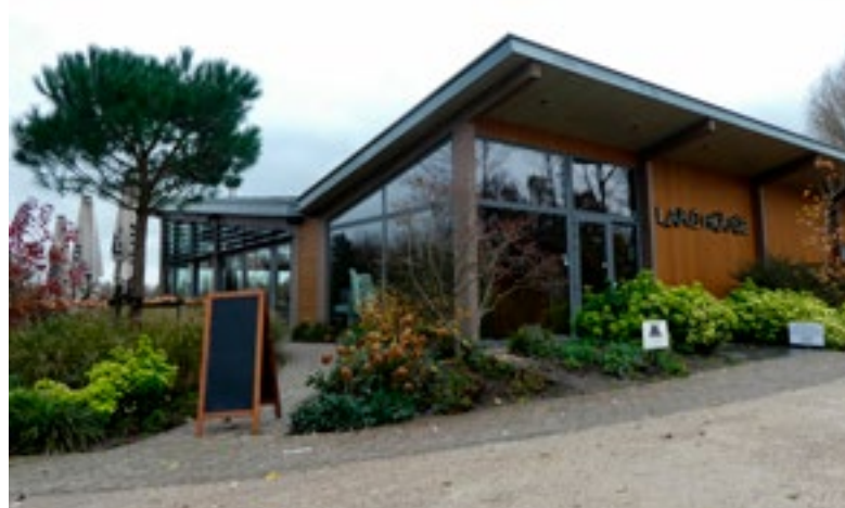
Lake House Rotterdam in het Lage Bergse Bos.
