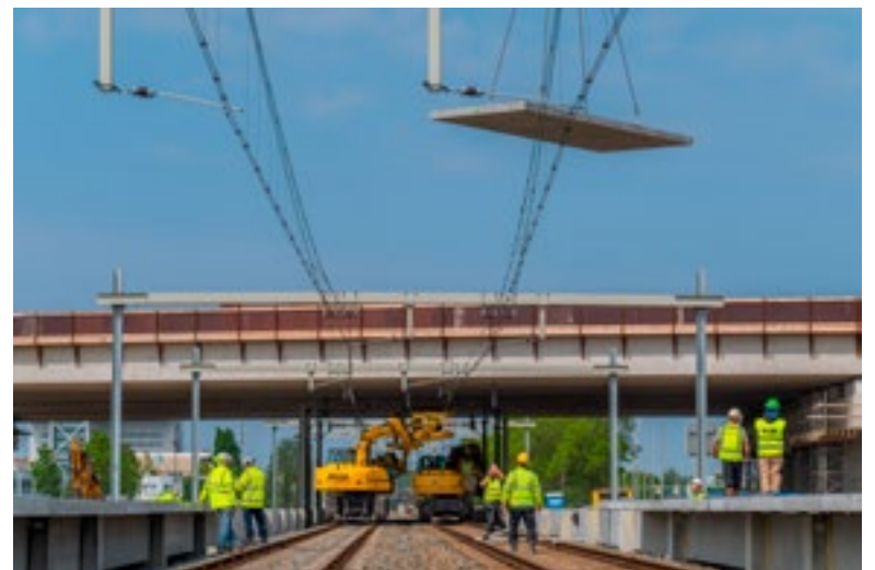
Het inmiddels schitterende station Lansingerland-Zoetermeer in aanbouw. (Foto: archief/Remco Zwinkels)
