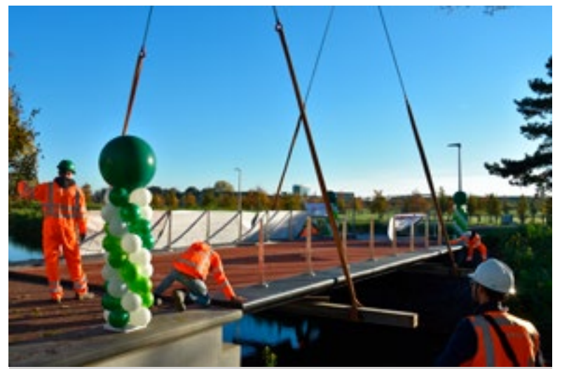
De dertien meter lange brug wordt op zijn plek geplaatst.
