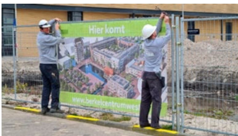
De heiwerkzaamheden gaan beginnen. (Foto: Gemeente Lansingerland)
