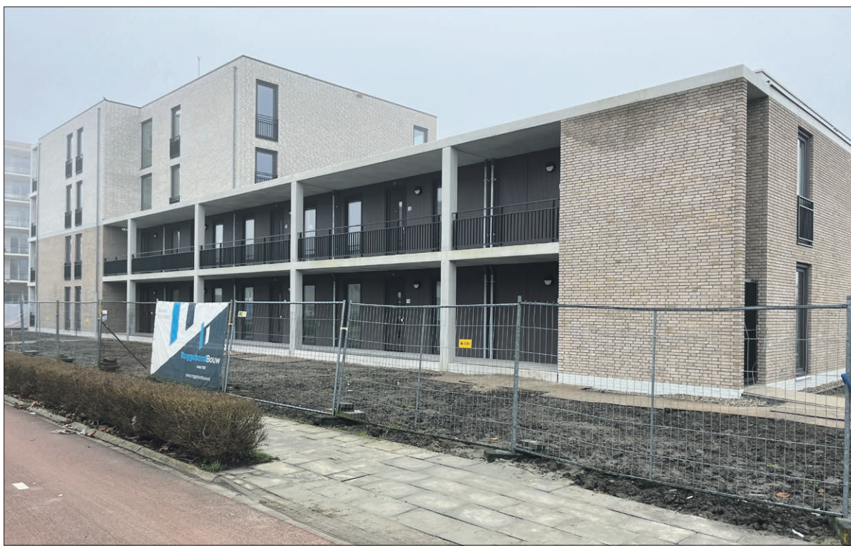
Het nieuwbouwproject Mdina in Zierikzee wordt half mei opgeleverd.
