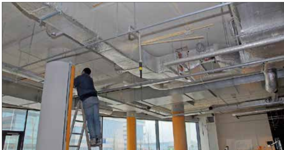
Laat zien dat u trots bent op uw werk tijdens de Dag van de Bouw.
