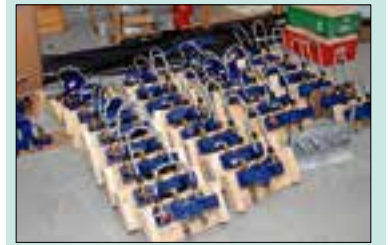
Kranen die zijn 'geprefabd' staan klaar om te worden gemonteerd.
