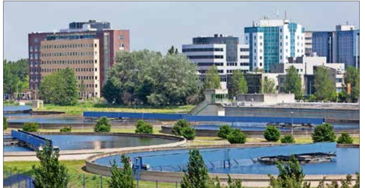
Afvalwaterzuiveringsinstallatie Kralingseveer in Capelle aan den IJssel zuivert dagelijks het afvalwater van ruim 360.000 inwoners uit Rotterdam en Capelle aan den IJssel.
