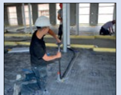
Installateurs leggen Geberit PushFit aan in de Leyhoeve.
