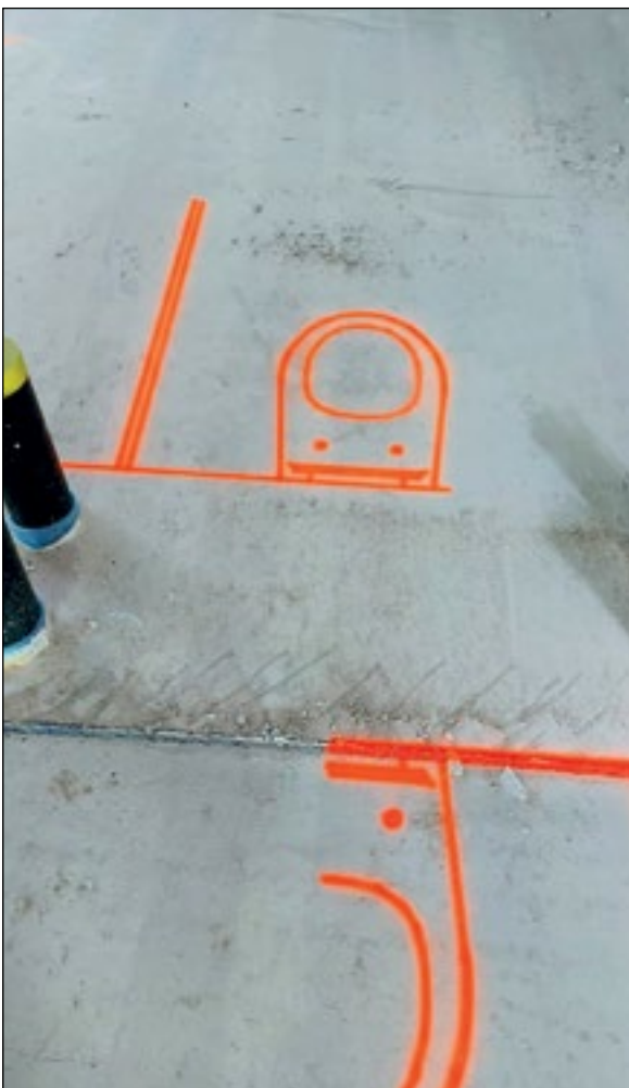
De robot heeft exact uitgetekend waar de toiletten moeten
