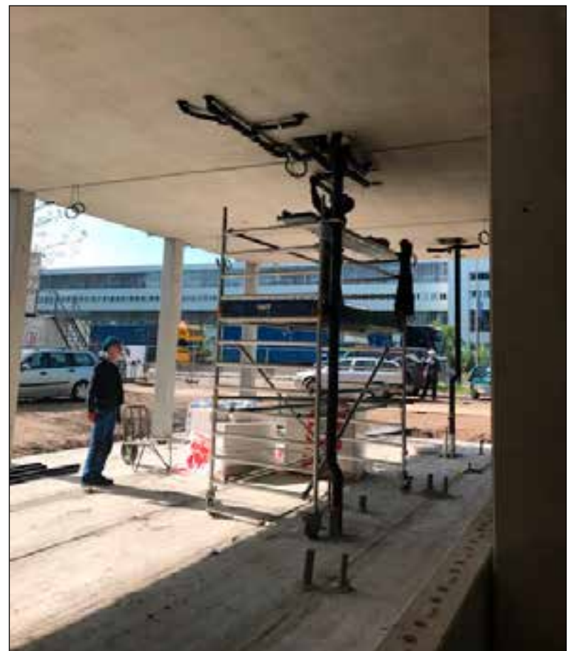
Installateurs van Rademaker leggen de leidingen aan.
