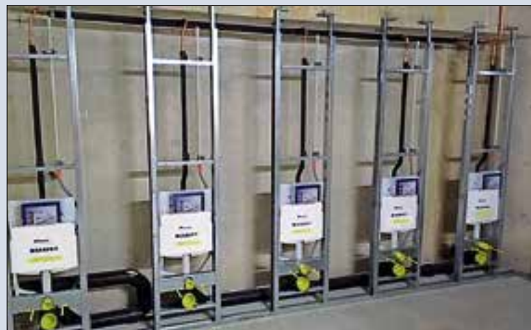
Geberit Huter installatiwand in het Groninger Forum.
