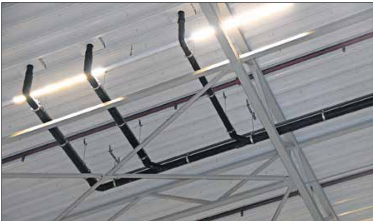
De afvoerleidingen van de noodoverstort zijn duidelijk zichtbaar onder het dak van de hal.
