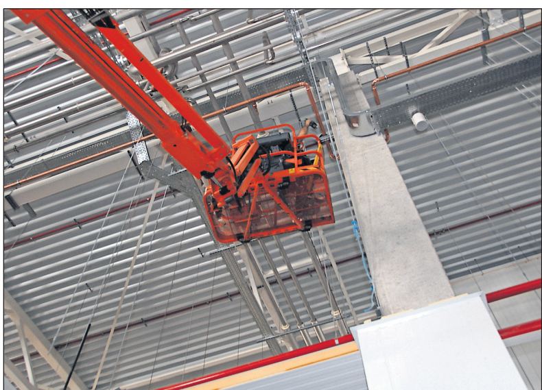
Een installateur monteert op grote hoogte leidingen.
