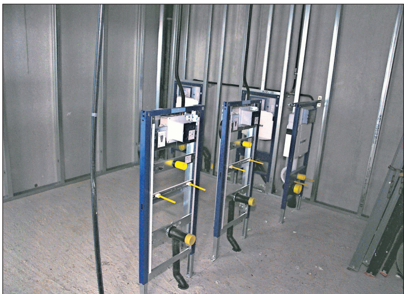
In de toiletten worden waterbesparende inbouwreservoirs van Geberit geplaatst.
