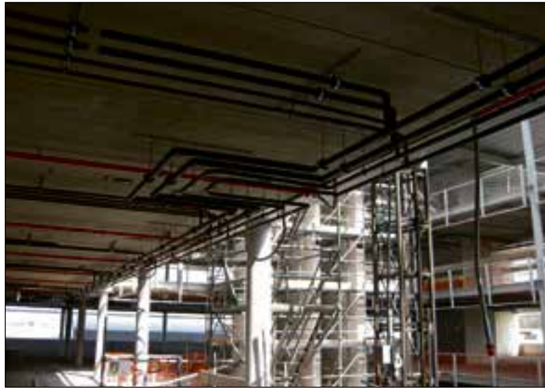
De leidingen lopen over het plafond.
