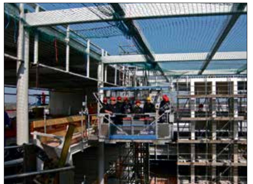
De installateurs van Heesmans werden elke dag in het kader van lean werken in een speciaal 'bakje' naar hun werkplek gehesen.
