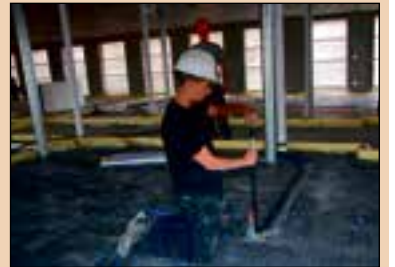
In de vernieuwde NEN-norm 1006 staan wijzigingen die van groot belang zijn bij de installatie van leidingen.
